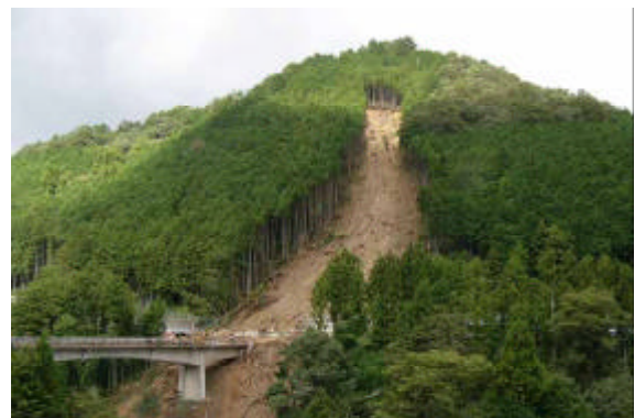
図-4 豪雨により樹木を巻き込んだ山崩れが発生 (H16.9 三重県)
