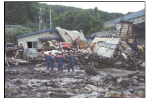
人家等に壊滅的被害 （土石流等被害）
