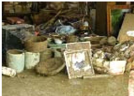
家の中に大量の土砂が （床上浸水被害）
