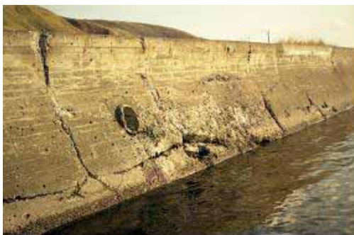
堤防の表法被覆工が損傷
