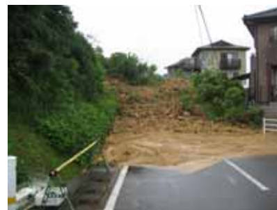
市道八幡御鉾ヶ浦線 （宮崎県日向市細島）
