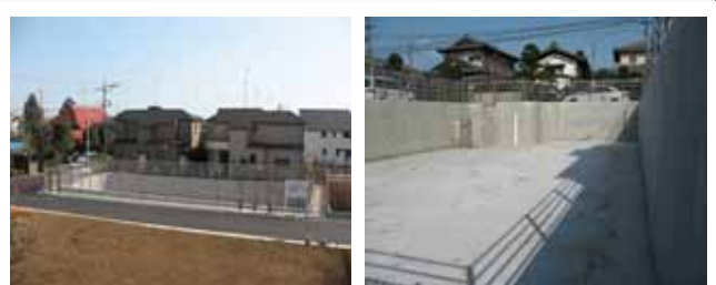
<雨水貯留浸透施設の例>
