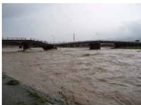
松田町道6号線・開成町道201号線十字橋 （神奈川県足柄上郡松田町惣領）
