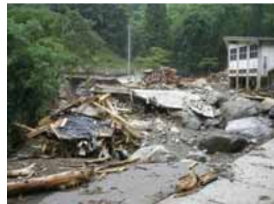
一級河川柏川 （熊本県下益城郡美里町柏川）
