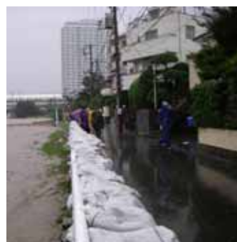
水防活動状況 （多摩川、東京都世田谷区二子玉川）
