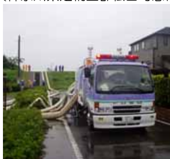
排水ポンプ車による排水活動状況 （鎚川、群馬県高崎市）
