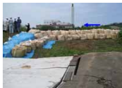
大型土のうによる応急復旧 （鯖石川、新潟県柏崎市橋場町）
