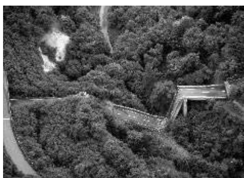
祭時大橋 (岩手県一関市)
