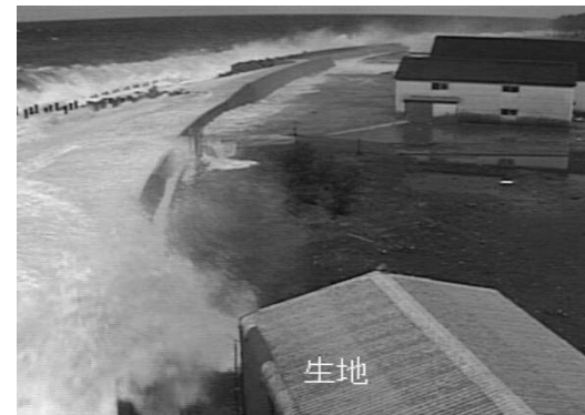
越波の状況（富山県黒部市生地地区）
