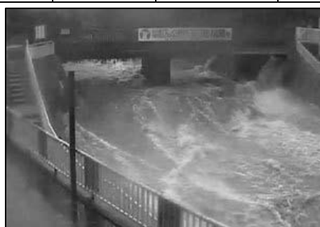
都賀川の出水状況
