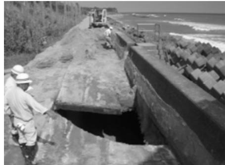
侵食による堤防天端の陥没
