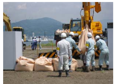
堤防応急復旧訓練
