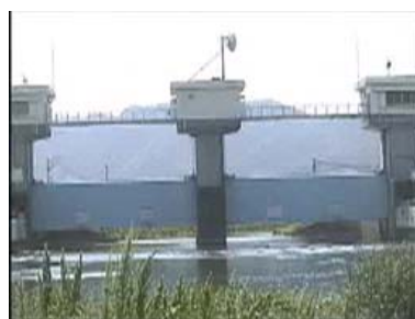
水門・陸閘閉鎖訓練
