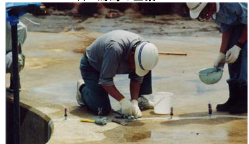
コンクリート護岸ひび割れ補修（H11年9月撮影）
