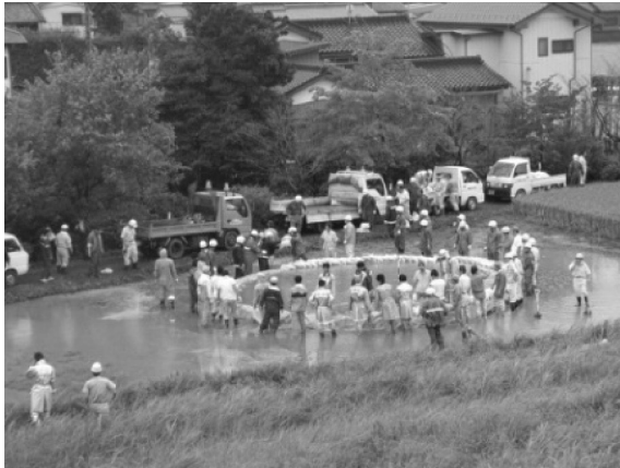
H13 利根川右岸の漏水状況（埼玉県加須市）
