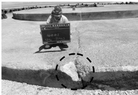
類似画像検索によりコンクリート 護岸の剥落等を自動的に検知
