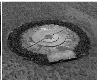
沖ノ鳥島（北小島護岸）の維持管理 (ひび割れの補修状況)
