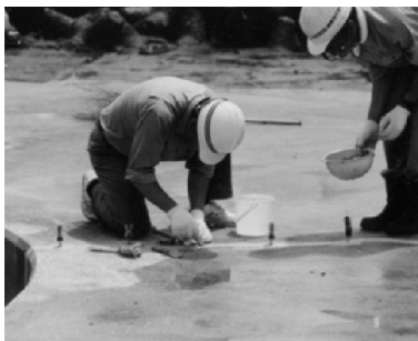
沖ノ鳥島（北小島護岸）の維持管理 (ひび割れの補修状況)
