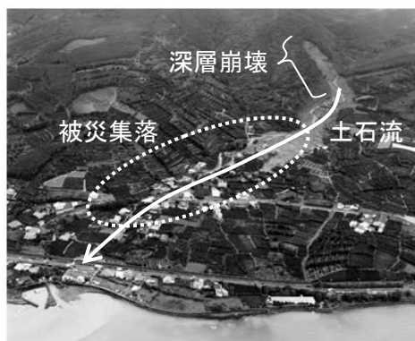
深層崩壊で生じた土石流の流下による被害 (鹿児島県出水市、平成9年7月)
