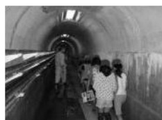
施工中のダム内部を見られる見学ツアー
