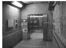
堤体内に設置されたエレベータを見学に利用
