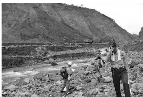
天然ダム決壊現場と現地調査状況
