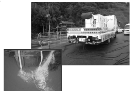
浸水対応のための排水ポンプ車の出動
