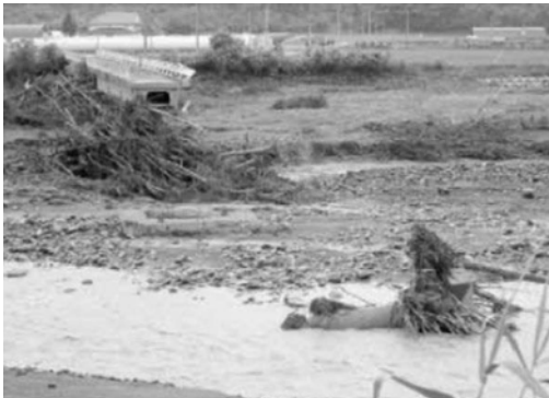
流木により流失した橋梁
