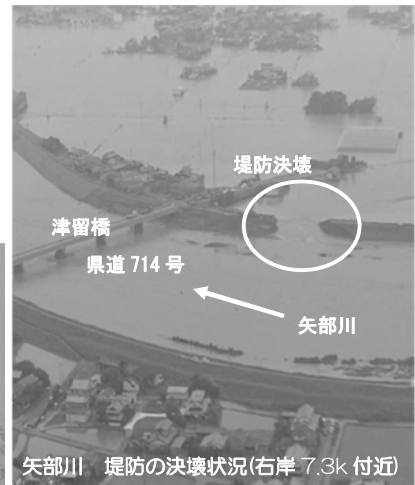
矢部川 堤防の決壊状況(右岸 7.3k 付近)
