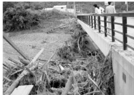
流木が引っ掛かり流下阻害が生じている例
