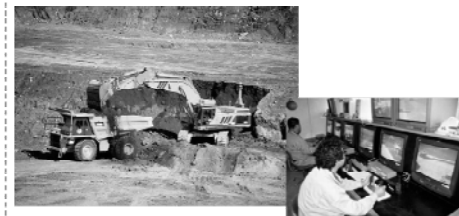
遠隔操作の状況
