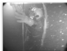
①貯水池内での水中作業（仮締切）
