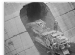
②ダム本体削孔
