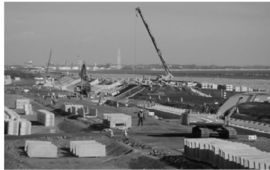
復旧工事実施状況
