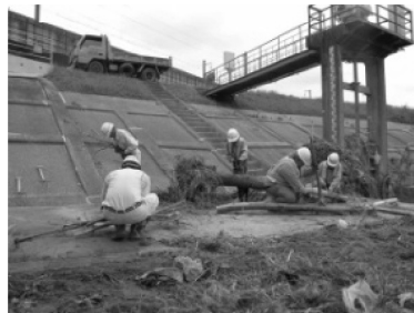
樋門吐口に堆積した塵芥の処理
