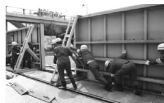
陸閘の閉鎖作業
