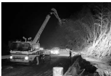
照明車による夜間作業支援状況
