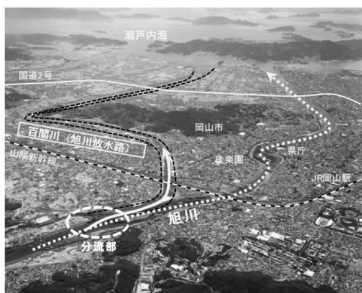
あさひかわ 【例】旭川放水路（岡山県）
