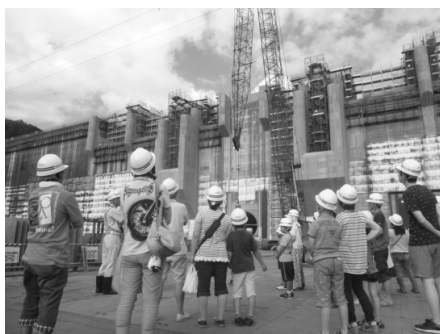
ダム本体の施工現場を見学
