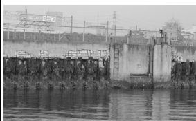
鋼矢板の腐食・コンクリートの劣化、堤防のひび割れ
