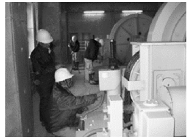
ダム放流設備点検状況
