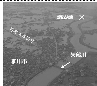
矢部川の被災状況（福岡県柳川市）
