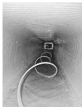
更生工法を施した管渠
