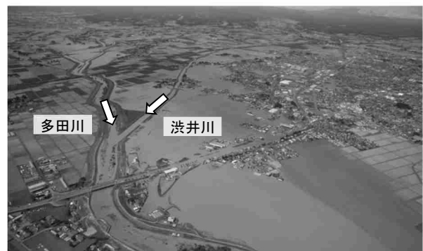
宮城県 大崎市 浸水状況
