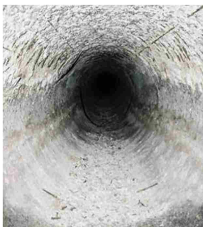
硫化水素で腐食した管渠
