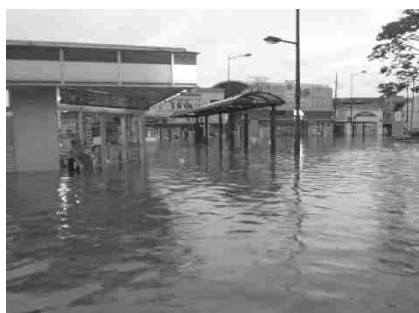
平成 27 年 9 月の浸水被害 (越谷市)
