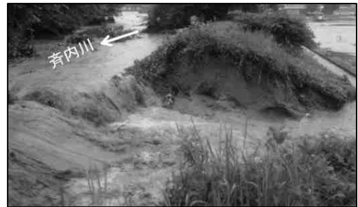
秋田県 大仙市 斉内川の堤防決壊状況
