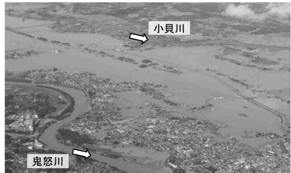
茨城県 常総市 浸水状況
