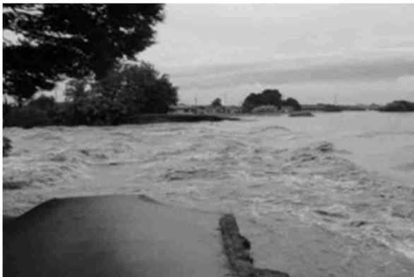
茨城県 常総市 鬼怒川の堤防決壊状況
