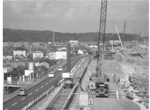
海岸堤防の耐震・液状化対策（高知県高知市）
