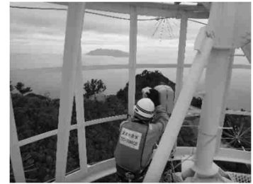
鹿児島県 屋久島町 口永良部島を捉える監視カメラの設置
