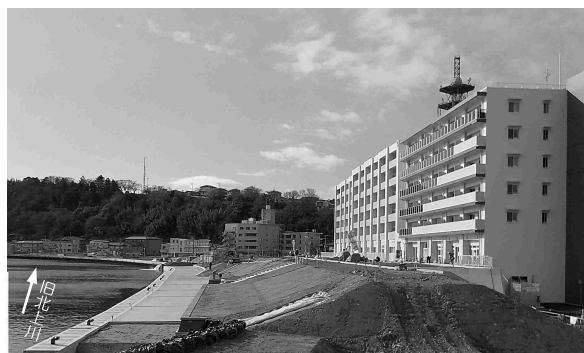
石巻市中央地区再開発事業及び河川堤防の整備状況
