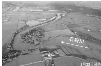
石狩川における被害状況
