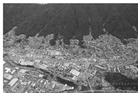
広島県広島市 みどりい 緑井・ やま 八木地区
