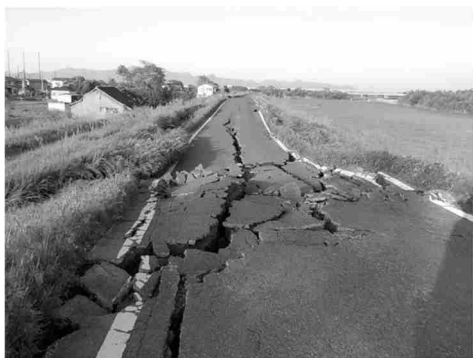
堤防損傷（緑川左岸 8k400 付近） （熊本市南区富合町上杉）
