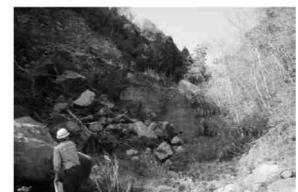
土砂災害危険箇所の緊急点検
