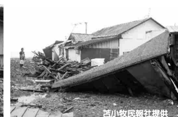
高波による被害状況 (胆振海岸、苫小牧市)
