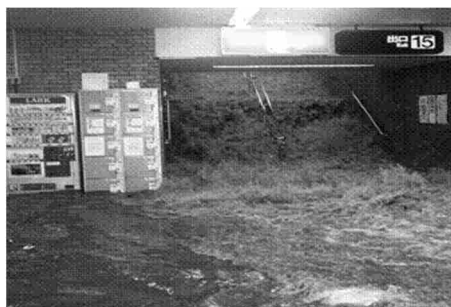
福岡市営地下鉄博多駅の浸水状況 (平成 15 年 7 月)
