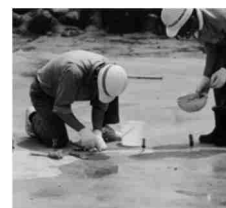
クラック補修状況（注入工）
