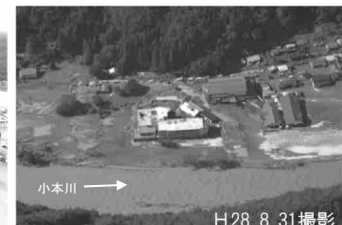
小本川における被害状況
