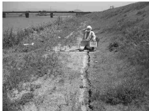
堤防損傷（緑川左岸 10k000 付近） （熊本市南区富合町釈迦堂）
