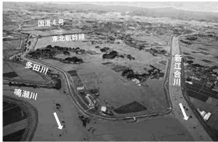
鳴瀬川支川の堤防決壊による浸水被害 (平成27年9月 関東・東北豪雨)
