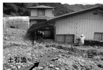
土石流による被害状況 (岩手県岩泉市)
