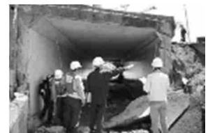
道路施設の被害状況調査
