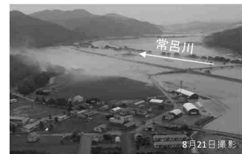
常呂川における被害状況
