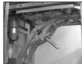
換気口浸水防止機
