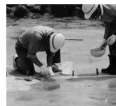
クラック補修状況 (注入工)
