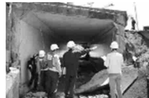
道路施設の被害状況調査
