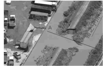
猪之子川の決壊箇所（広島県福山市） （応急復旧に23日15時に着手 24日9時30分完了）
