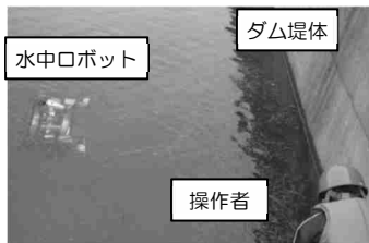
水中ロボットによる点検状況
