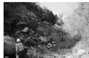
土砂災害危険箇所の緊急点検
