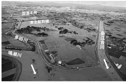
鳴瀬川支川の堤防決壊による浸水被害 (平成27年9月 関東・東北豪雨)
