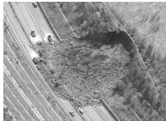
土砂崩落による道路の寸断 (大分県由布岳)
