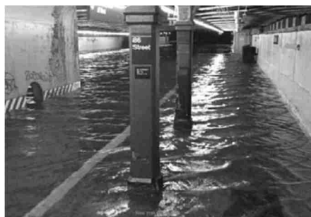
ニューヨーク地下駅の浸水状況 (平成 24 年 10 月) (現地調査時 MTA 提供)
