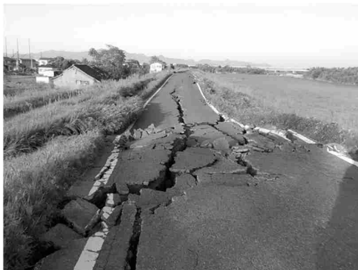
堤防損傷（緑川左岸 8k400 付近） 熊本市南区 とみあいまちはみすぎ 富合町上杉
