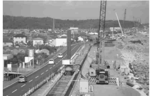
海岸堤防の耐震・液状化対策（高知県高知市）
