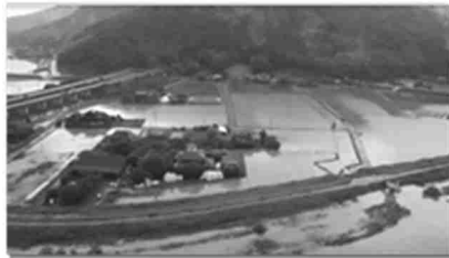
六角川における出水の状況 (佐賀県武雄市橋町付近)
