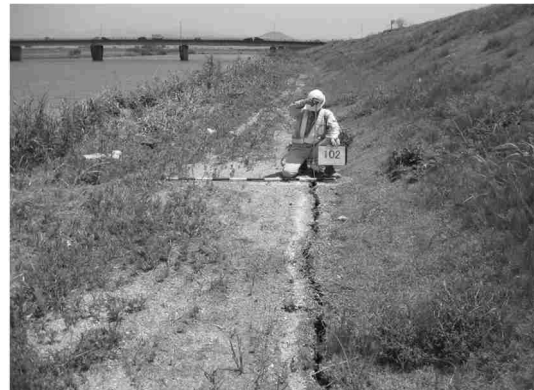
堤防損傷（緑川左岸 10k000 付近） 熊本市南区 とみあいほちしゃかどう 富合町釈迦堂
