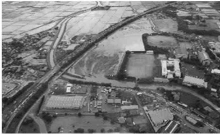
桂川沿川の浸水被害（福岡県朝倉市）
