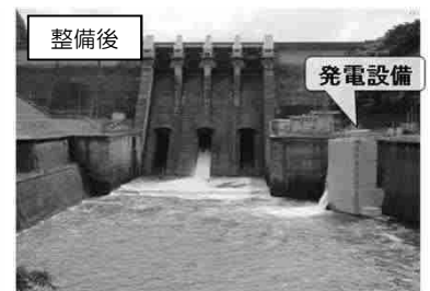
ダム管理用発電設備の設置例
