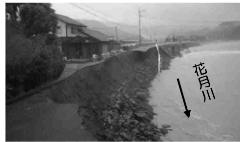
堤防洗掘 (花月川右岸 6.4k 付近) 大分県日田市
