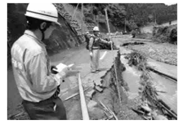
県道 509 号の被害状況調査
