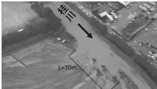
堤防決壊 (桂川右岸) 福岡県朝倉市
