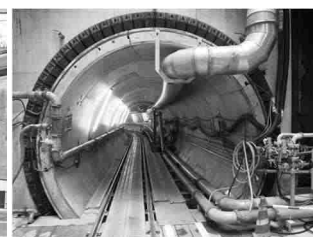
雨水貯留管の整備
