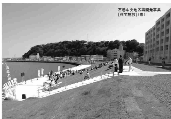
石巻市中央地区再開発事業及び 河川堤防の整備状況（平成 29 年 6 月）
