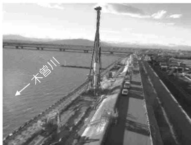
河川堤防における地震・津波対策 （三重県木曾岬町）
