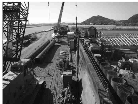
海岸堤防の耐震対策（高知県南国市）
