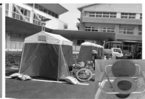
マンホールトイレの設置例 (熊本市)
