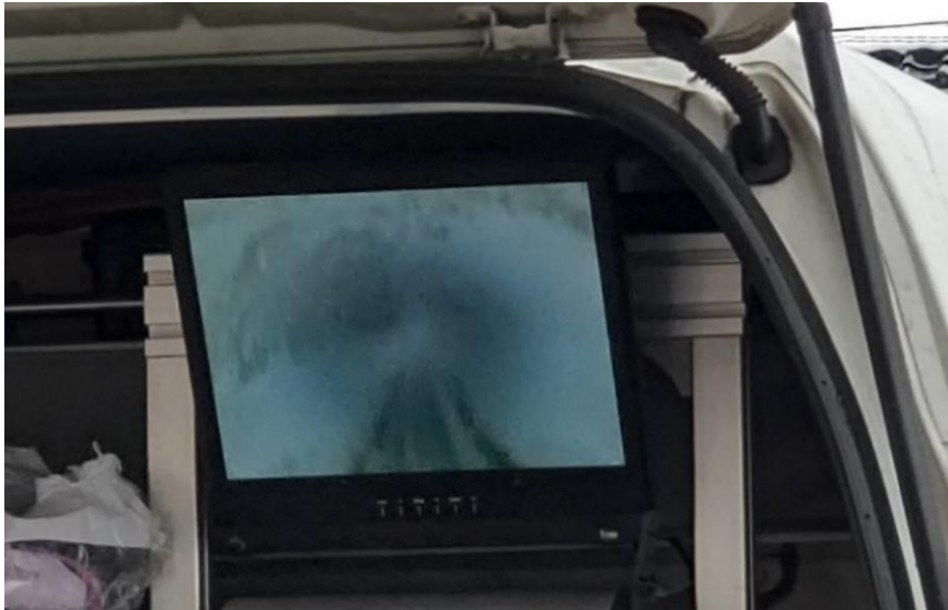
■ 1/27 2次調査(TVカメラ調査における管内の様子)(中能登町)
