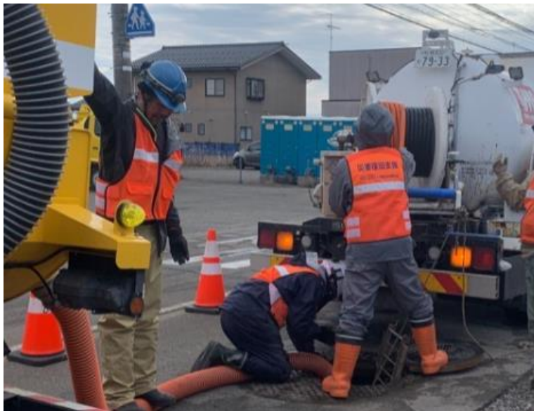
■ 1/30 2次調査(内灘町)
