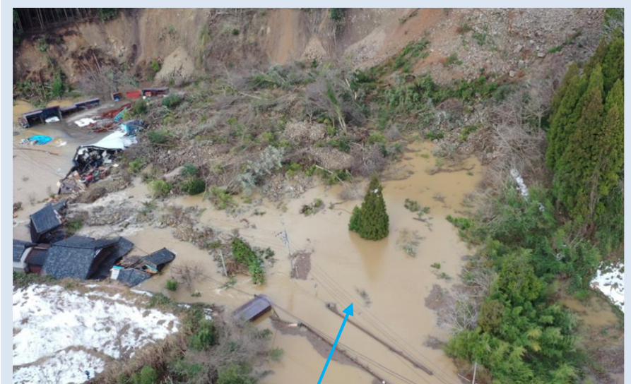
1月4日 ドローン調査状況
