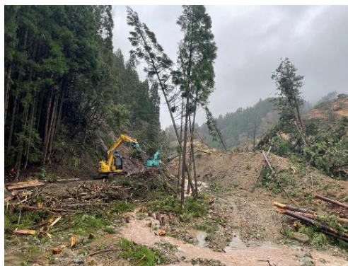
応急対策工事状況（紅葉川） 仮設道路整備（倒木撤去作業）
