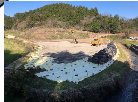
応急対策工事状況（鈴屋川（牛尾川）） 作業ヤード整備
