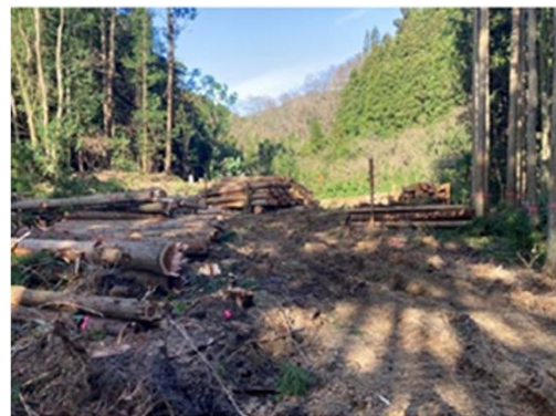
応急対策工事状況（寺地川） 作業ヤード整備
