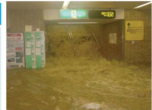
地下街の浸水状況 (平成15年7月福岡水害(博多駅))
