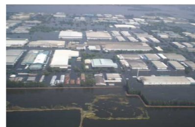
タイ国ロジャナ工業団地の浸水状況（平成23年10月）
