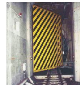
トンネル内防水ゲート
