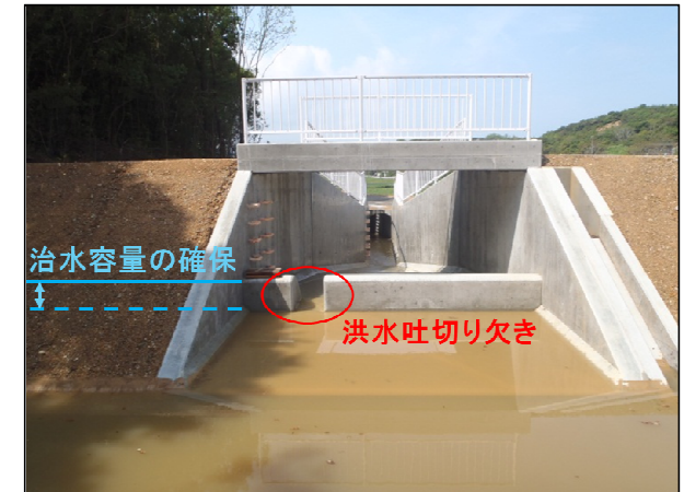
洪水吐切り欠きの設置により治水容量の確保を行った事例
