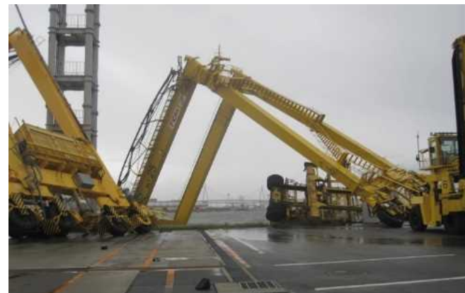
トランスファークレーンの被災状況 (大阪港北港南C10 - C12)
