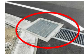
道路上の排水施設
