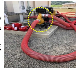
下水処理場等における仮設揚水ポンプの確保(イメージ)
