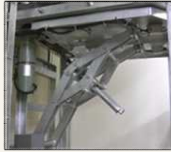
換気口浸水防止機
