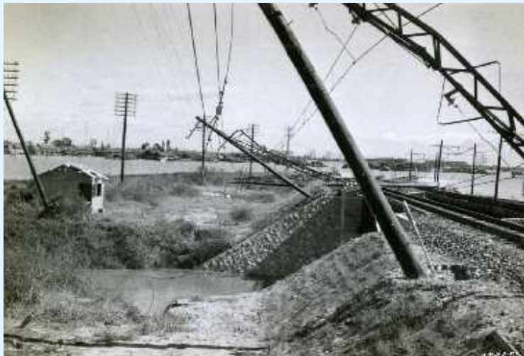
【鉄道の被災状況】
