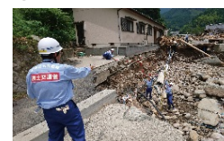
公共土木施設の被災状況調査
