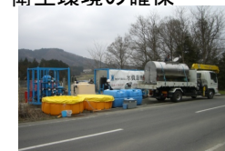
緊急時の水供給を可能とする連携体制の構築
