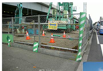
復旧工事の集中・輻輳
