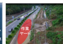
被災鉄道の早期復旧のための河川・道路事業等との連携
