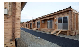
被災者向け住宅 (東日本大震災)
