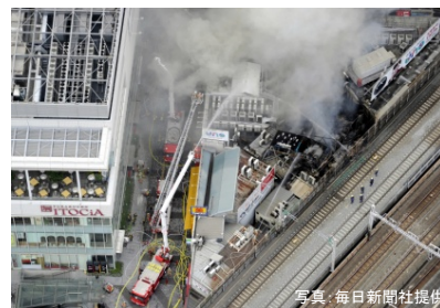
市街地火災による被災で鉄道が運行停止が長期化
