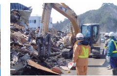
地域の建設業者による道路啓閉
