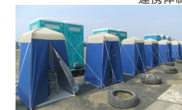
下水道施設の耐震化やマンホールトイレの整備等
