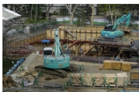
施工ヤードの不足
