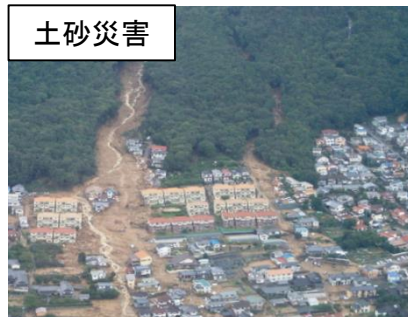
平成26年8月豪雨による 広島県で発生した土砂災害
