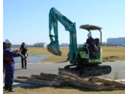
近畿地整職員による道路啓開訓練
