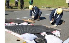
土のうの積上げ等による橋梁段差の解消
