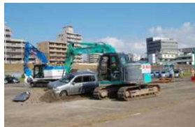
道路啓開訓練
