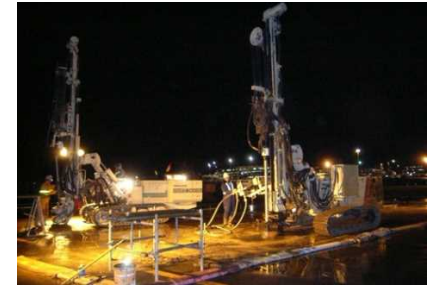
空港の耐震対策
