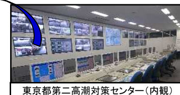
東京都第二高潮対策センター(内観)
