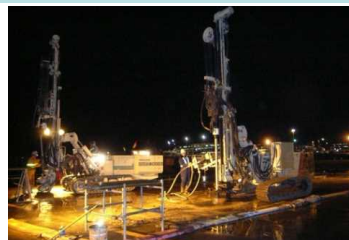
空港の耐震対策
