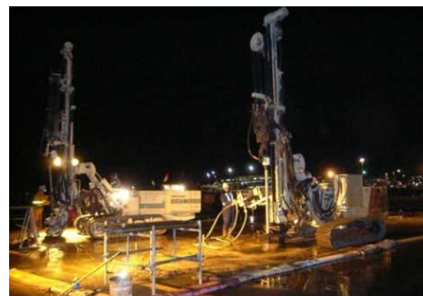
空港の耐震対策
