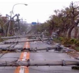
電柱の倒壊による道路閉塞
