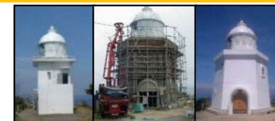
航路標識の耐震補強
