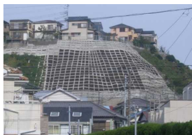
急傾斜地崩壊対策施設による対策事例
