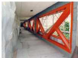
建築物の耐震改修の事例 (鉄骨ブレースによる壁の補強)
