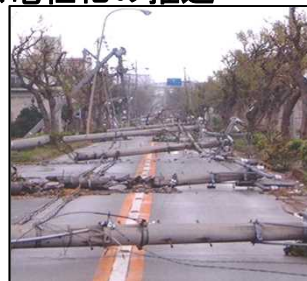
電柱の倒壊による道路閉塞
