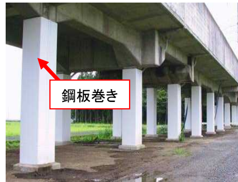
高架橋の補強
