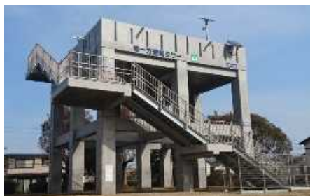
津波避難タワー
