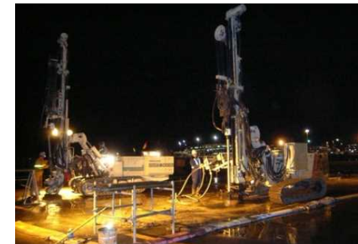
空港の耐震対策
