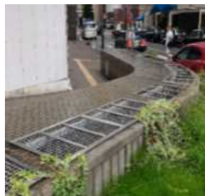
浸水対策の機能整備
