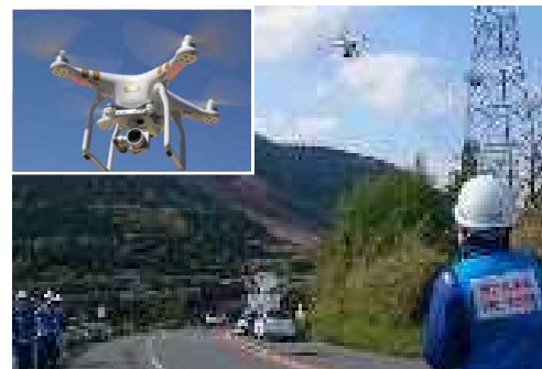
ドローンを活用した被害状況調査
