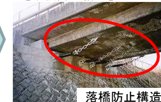
【落橋防止構造】
