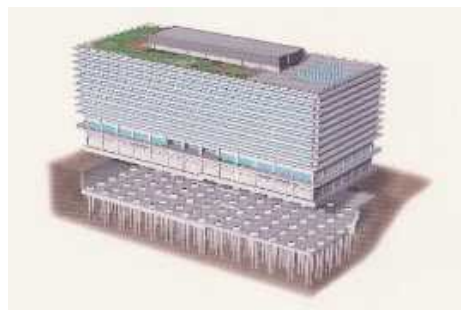
中央合同庁舎の免震化
