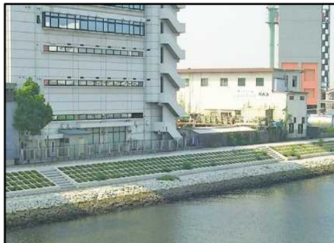
防潮堤の整備(東京都京浜運河)
