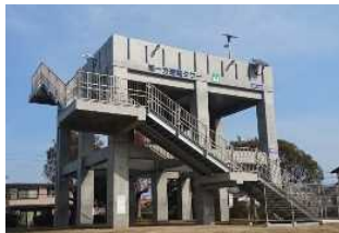
津波避難タワー
