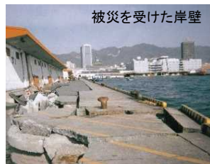
阪神淡路大震災時の岸壁の被災状況
