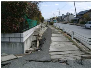
東日本大震災による液状化で浮き上がった埋設配管
