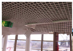
クラブハウスの天井が落下
