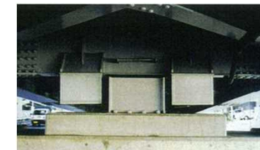
水平力を分担する構造
