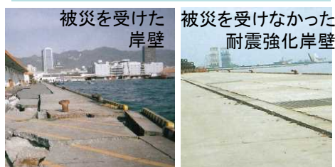
阪神淡路大震災時の岸壁の被災状況
