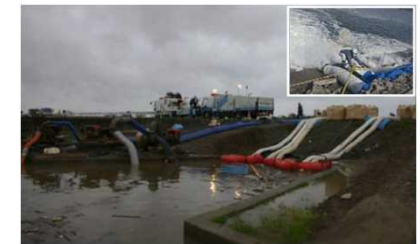
排水ポンプ車による排水 (東日本大震災)
