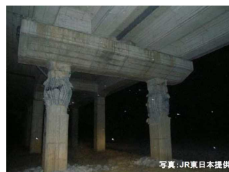
東日本大震災時の高架橋の損傷状況
