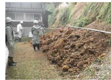
急傾斜地崩壊危険箇所の点検状況 (鳥取県倉吉市)
