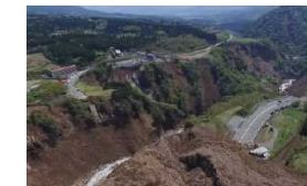
近づけない箇所の調査・測量を実施
