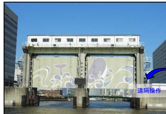
水門の遠隔操作化(東京都目黒川水門)
