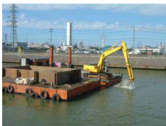
河川の維持管理（川底の浚渫工事）
