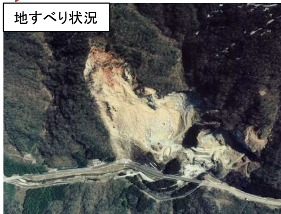
落石被災状況
