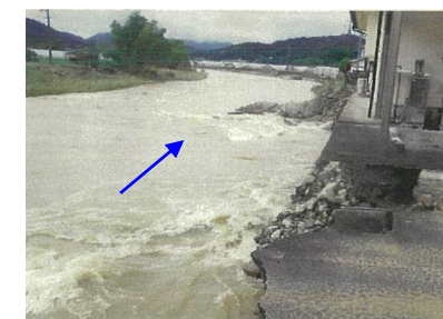
▲家屋の被災状況
