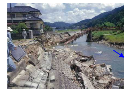
▲橋梁の被災状況
