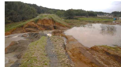
【堤防決壊状況】
