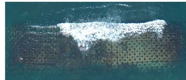
⑬人工リーフ 被災状況 被覆ブロック移動・散乱
