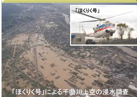
【令和元年東日本台風】 (長野県長野市上空)
