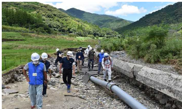
被災状況調査
