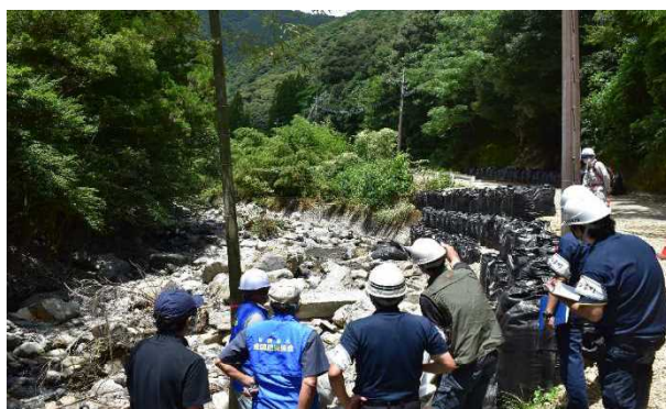
被災状況調査
