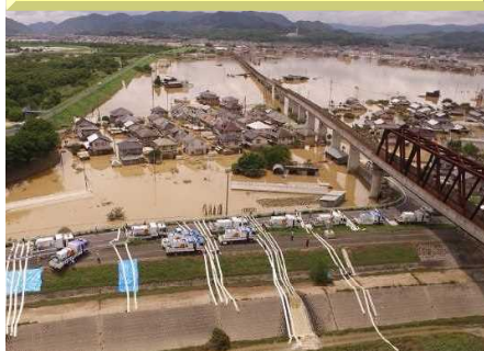
【H30.7月豪雨】 (岡山県倉敷市真備町)
