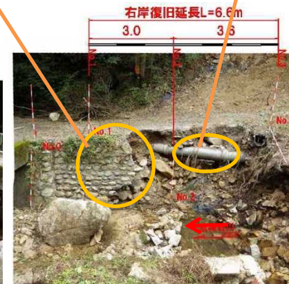
写真-56 B 右岸・全景写真
