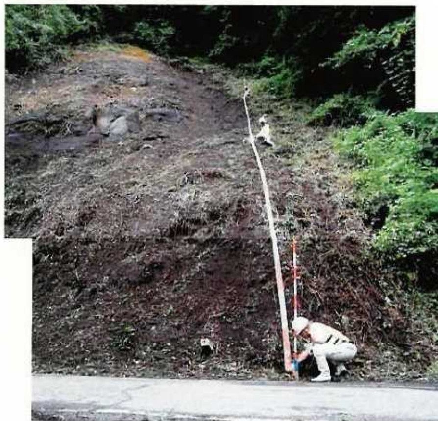
法面復旧起点(道路側より)
