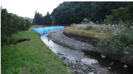
前後護岸と同等の決壊防止対応(土嚢積みのほか、ブルーシートによる侵食・浸透防止)
