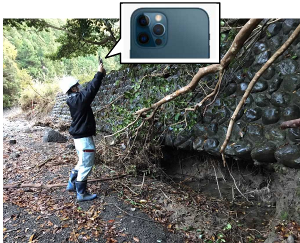
職員によるタブレット端末での点群計測
