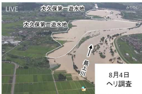
【遊水地への湛水状況(令和4年8月4日)】
