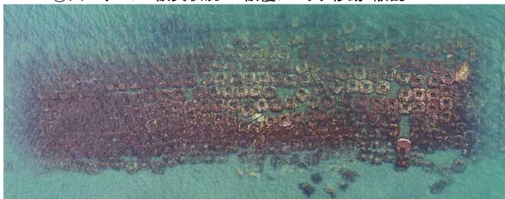
⑬人工リーフ 被災状況 被覆ブロック移動・散乱
