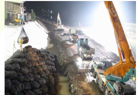
大分県建設業協会による災害対応 (平成29年九州北部豪雨)
