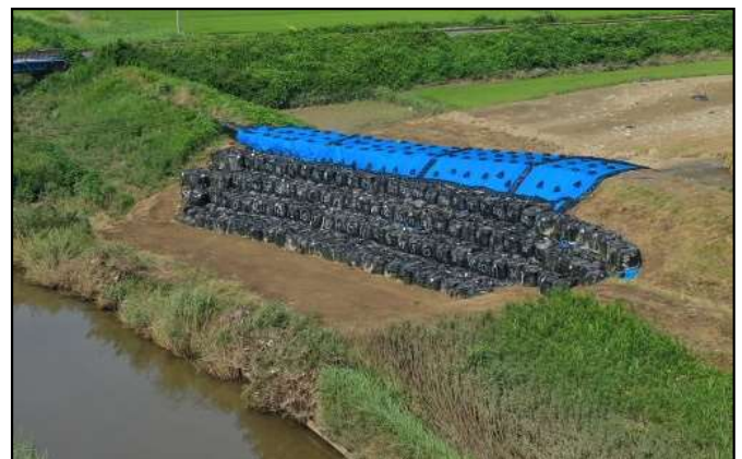
土堤+大型土のう
