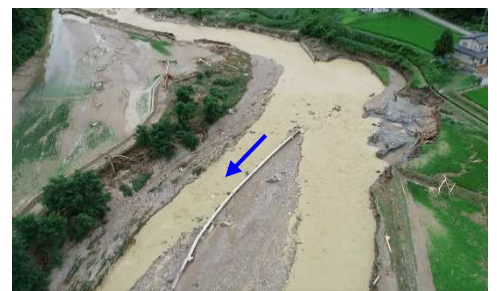
▲河岸侵食状況
