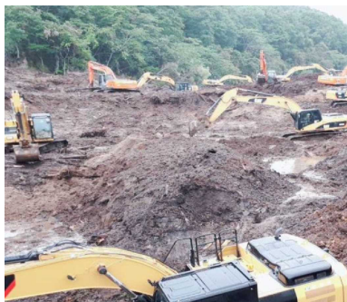
北海道建設業協会による災害対応 (平成30年北海道胆振東部地震)
