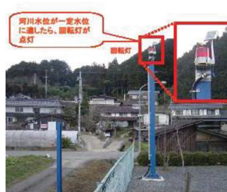
回転灯の設置
