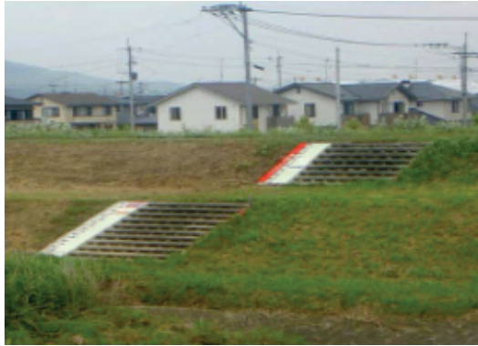
水位標の設置
