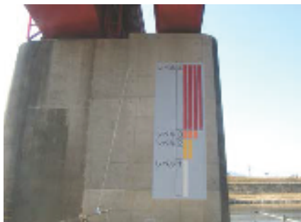
水位表示の例（橋げた）
