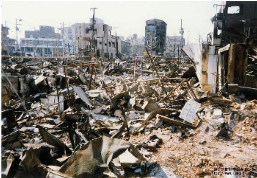
写真：消防科学総合センター
