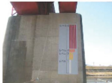
水位表示の例（橋げた）
