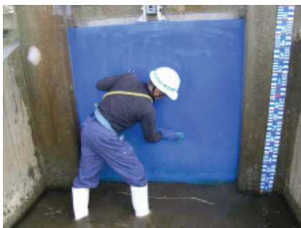
樋門ゲートの点検
