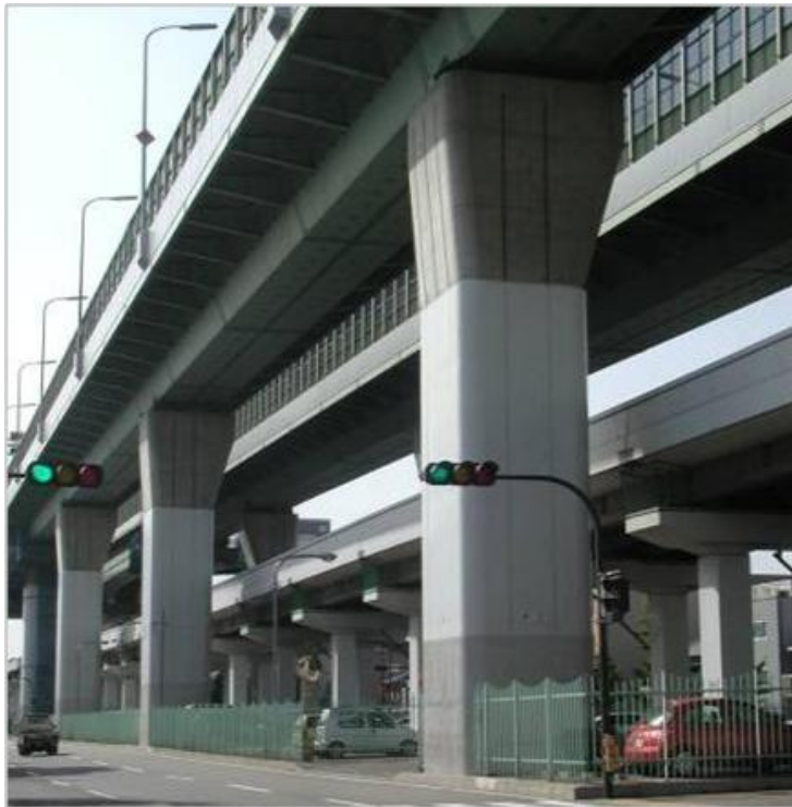
阪神高速道路の橋脚
