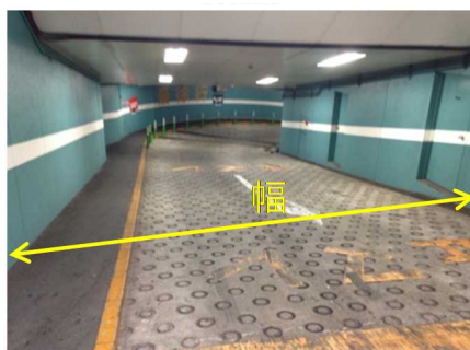
地下駐車場の出入口
