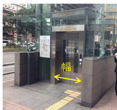
エレベーター
