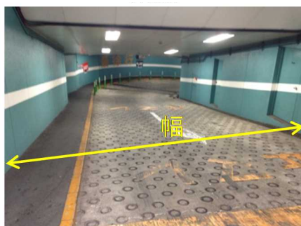
地下駐車場の出入口
