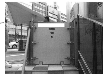
浸水深の深い東側は防水板（脱着式）を採用
