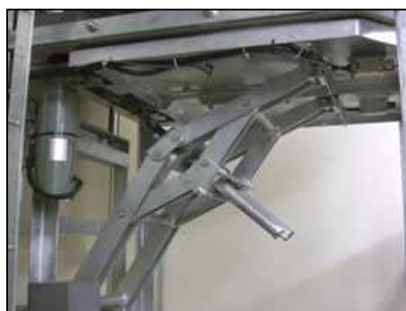
換気口浸水防止機
