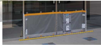
1階出入口⇒持ち運びタイプ・シート式（竣工後導入） *最大止水高さ：500mm
