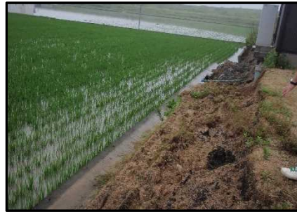
塩屋地区住宅敷地一部崩落
