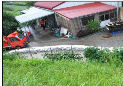
万願寺川左岸(粟生地区) 月の輪工
