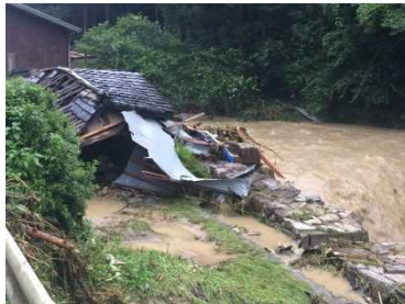
大瀬中央の浸水被害
