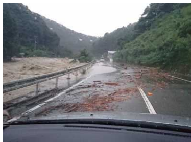
麓川右岸 巡視
