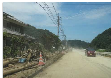
④被害状況(立岩)
